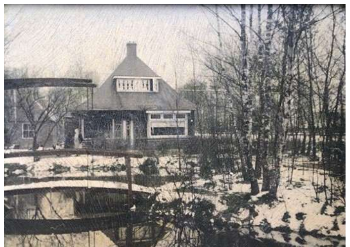
De door Bernard zelf gebouwde woning met vijver en ophaalbrug. Op de achtergrond de echtgenote van Bernhard
