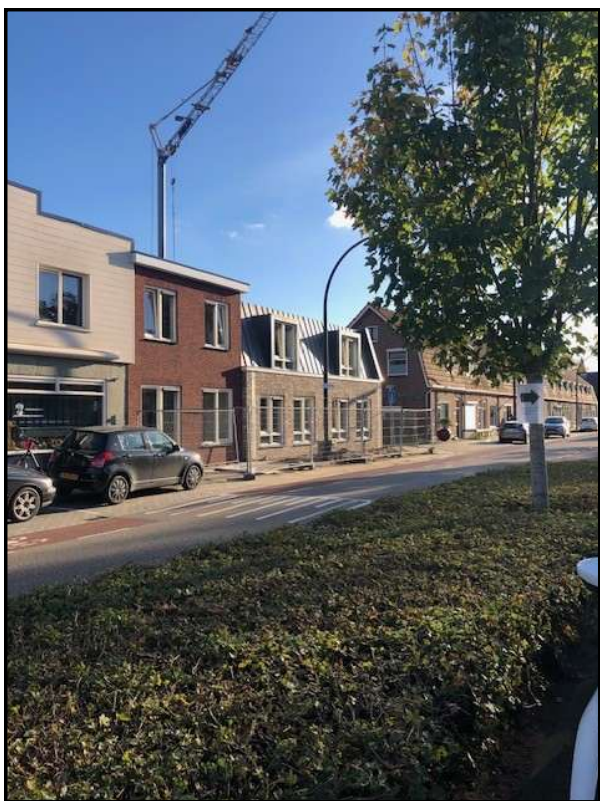
Nieuwbouw op de hoek van de Deldensestraat en de Weideweg
