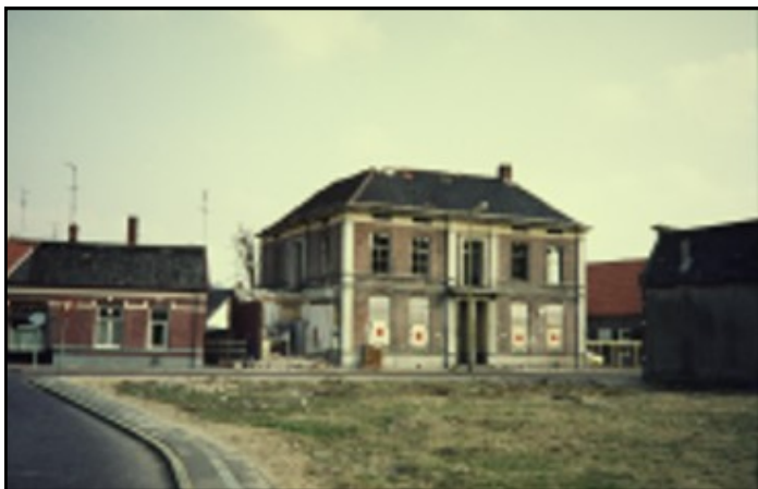
Het Spanjaardhuis, gereed op gesloopt te worden. De aangebouwde slagerij is reeds gesloopt.
