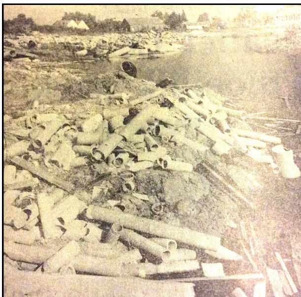
Resten van Eternitbuizen gestort in het kleigat
