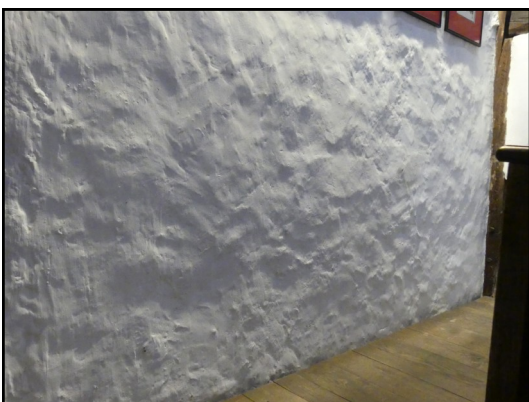
De oorspronkelijke lemen wand in het huis
