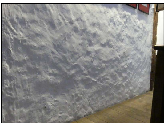
De oorspronkelijke lemen wand in het huis
